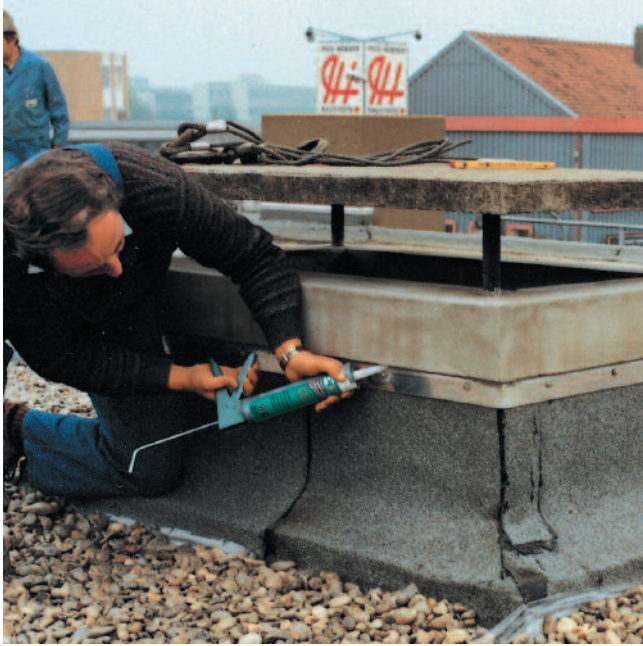
Elastisches Schließen von Anschlussfugen an einem Kamin zwischen Beton und Edelstahlverwahrung.
