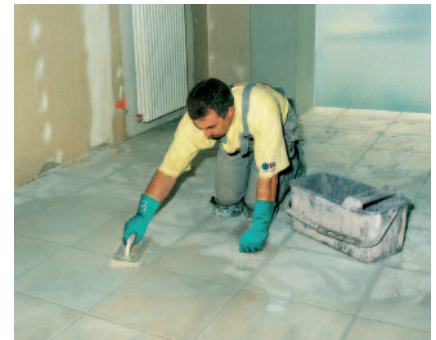
Mit PCI Flexfug können Fugen von 2 bis 10 mm bzw. von 3 bis 15 mm (abhängig vom Farbton) rissfrei verfugt werden.
